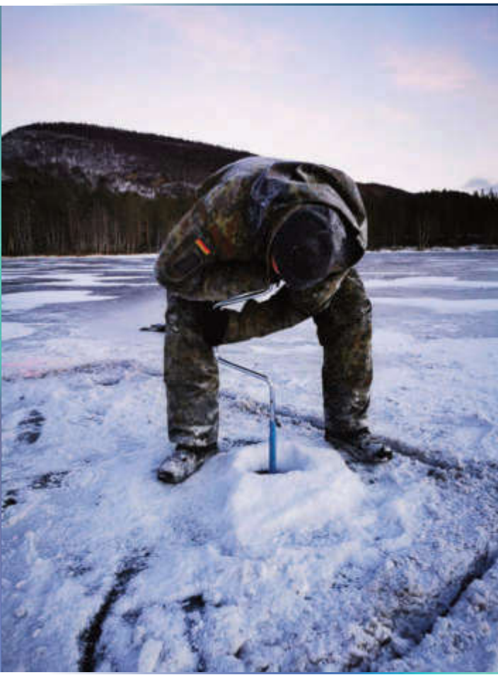
Ein Gebirgspionier bereitet ein Eisloch für eine Sprengung vor.
